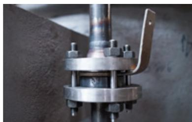
Einstellblende zur Regulierung der Dampfmenge für die Eindüsung
