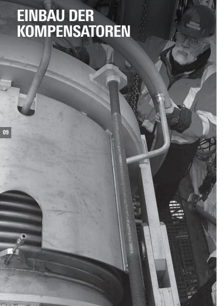
Durch den Einbau von Kompensatoren in eine Rohrleitung verändert sich deren Verhalten zum Teil erheblich. Festpunkte und Führungen werden anders beansprucht und müssen andere Aufgaben übernehmen als bei einer unkompensierten Leitung.
