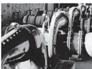
Bild 8.16 Axial-Kompensator als Ausbaustück
